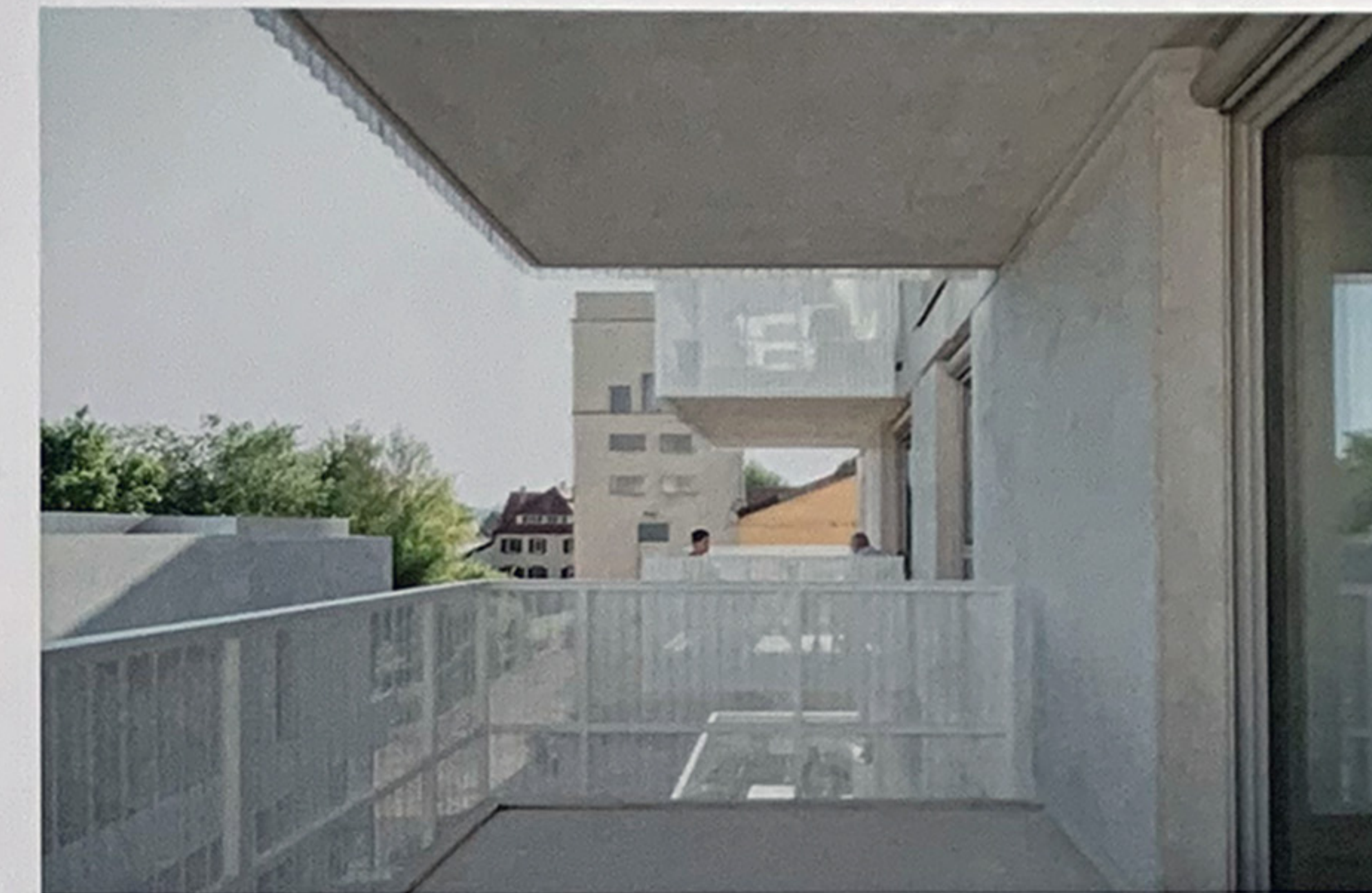
Balkone mit halbdurchsichtiger Brüstung
